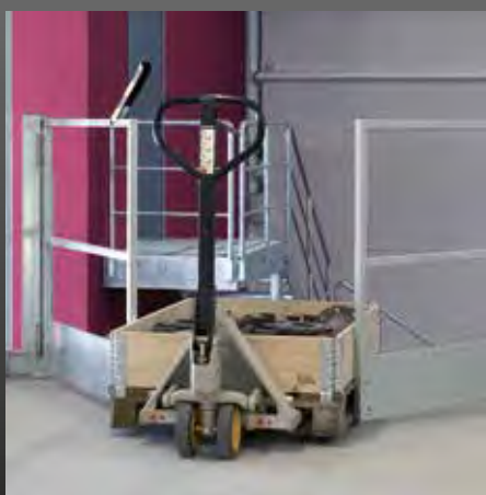
Übergabestationen auf beiden oberen Ebenen.
